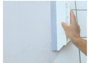
Poser et faire pression sur les pièces en tapant fortement dessus, pour un bon nivelage des sillons et pour assurer un bon transfert de la colle.
