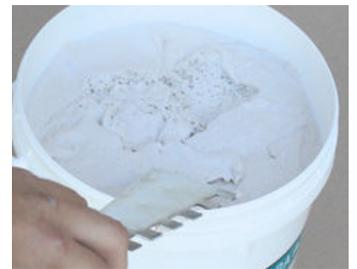
Passer une taloche dentée de dimension adaptée à l'épaisseur souhaitée (maximum 6x6mm). Appliquer la pâte en petits pans.
