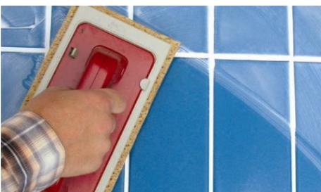
5. Efetuar a limpeza da cerâmica com água limpa morna à medida que se vai aplicando. Utilizar uma talocha de limpeza abrasiva ou uma máquina de limpeza, de forma a efetuar uma limpeza geral. Na betumação a circulação pedonal pode ser efetuada após 8 horas. A largura das juntas é de 3 a 10mm.
