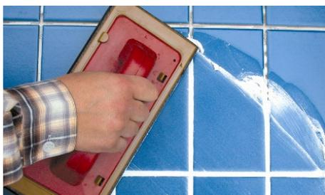
4. Para pequenas áreas aplicar manualmente com uma talocha de betumar dura (ver capítulo - Máquinas, Ferramentas e Acessórios). Aplicar na diagonal em relação às juntas de modo a garantir o enchimento total das juntas. Em grandes áreas aplicar à pistola pneumática (ver capítulo - Máquinas, Ferramentas e Acessórios). Alisar as juntas e retirar o excesso de Topcola Epoxy com a talocha de betumar dura.
