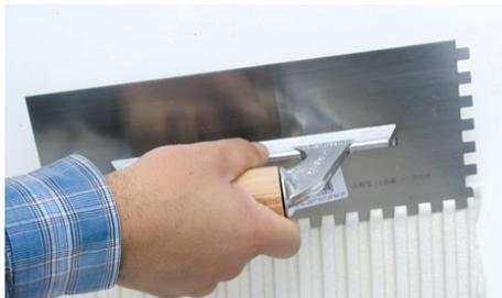
3. Estender Topcola Epoxy com uma talocha dentada. Bater nas peças para assegurar uma transferência total da argamassa sobre as costas das peças. Na colagem o tempo de secagem ótimo é de 4 dias a 20°C.
