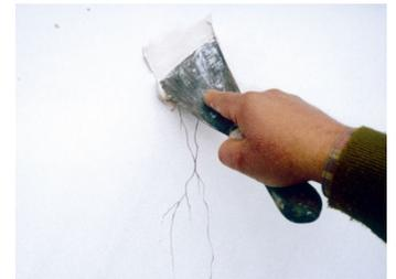
Lézarde: plus profonde que la fissure, la remplir peut ne pas être suffisant, le problème risque de réapparaître.
