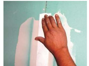
Recouvrir la bande avec une nouvelle épaisseur de Tuforte Juntas.
