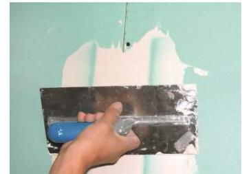
En cas d'utilisation de filet adhésif, la bande doit être collée aux plaques, avec le plis de la bande située à la jonction des deux plaques. Appliquer Tuforte Juntas sur les bandes et les compresser fortement.
