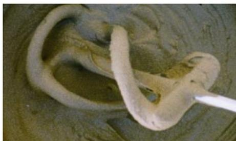
1. Misturar mecanicamente um saco de Tubetão G com cerca de 5,5 L de água limpa, com misturador a velocidade lenta, até obter uma pasta homogénea e de consistência plástica.
