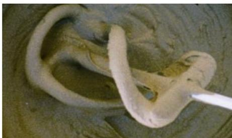
1. Misturar mecanicamente um saco de Tubetão FT com cerca de 10 L de água limpa, com misturador a velocidade lenta, até obter uma pasta homogénea e de consistência plástica.
