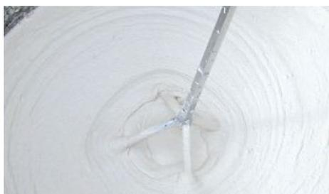
1. Verter o pó progressivamente sobre a água, na proporção um saco de Tuforte de Estanhar com cerca de 15-16 litros de água limpa. Deixar repousar entre 2 a 3 minutos.
