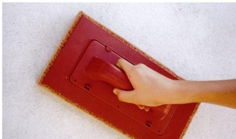
Tuforte Estanhar deve aplicar-se, diretamente sobre argamassa de reboco fresca, todavia a mesma terá de apresentar resistência suficiente para poder ser estanhado.
