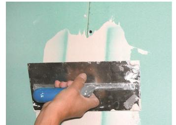
Pour les bandes de filet adhésif, coller la bande de filet aux plaques, centrer la bande sur la jonction de deux plaques. Appliquer Tuforte Aqua Plan sur les bandes, et les compresser fortement.
