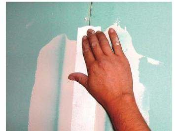
Recouvrir la bande avec une seconde couche de Tuforte Aqua Plan, l'enduit pour le recouvrement de la bande doit dépasser d'environ 10 cm des deux côtés.
