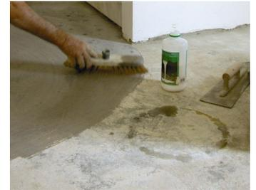
Gâcher la Betonilha Cem mécaniquement avec environ 3 litres d'eau, jusqu'à l'obtention d'une pâte homogène. La chape devra avoir la consistance de "terre humide".
