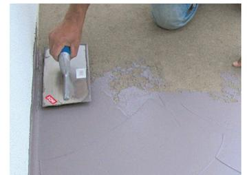
Cas où vous souhaitez revêtir la superficie, le collage pourra être effectué en utilisant le même produit. Appliquer le Topelastic K2 avec une taloche crantée, avec des dents de dimensions adéquates à l'épaisseur de la pièce. Coller les pièces en les secouant pour expulser l'air, en garantissant le total transfert de la colle.
