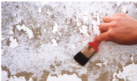
1. Aplicar o Anti-Salitre, com um rolo ou trincha até à saturação do suporte sobre as zonas a tratar. Posteriormente poderá aplicar um novo revestimento. Para evitar o aparecimento de sais na superfície revestir o suporte com Topeca Sane.
