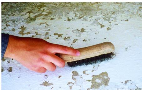
Os suportes devem estar limpos, secos, resistentes e sem óleos descofrantes. Remover todos os contaminantes da superfície com a ajuda de uma escova seca. Todas as infiltrações e fendas devem ser reparadas. Em suportes com baixa resistência eliminar revestimentos frágeis e proceder ao tratamento Anti-Salitre.
