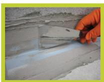
Cinta elástica em borracha com reforço de rede em polyeste para impermeabilização de juntas de dilatação para interiores e exteriores. Impermeável á agua e ao vapor de água. Resiste ás intempéries, aos alcalis e aos ácidos.
