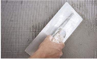
**1.2.2.** Colar a rede de fibra de vidro de cima para baixo com a ajuda de uma talocha metálica lisa. Estendê-la bem sem deixar foles (nunca eliminar os foles recorrendo ao corte da rede). Deve ficar espalhada a uma distância constante (1,5 mm) das placas de isolamento, e terá que ser sempre sobreposta cerca de 10 cm em todas as zonas de ligação. Regularizar a cola remanescente passando com talocha metálica lisa.
