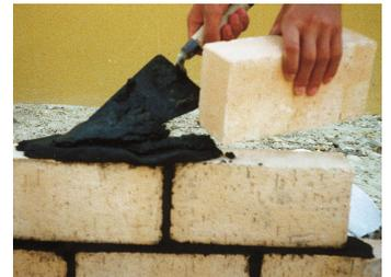
Remplir les joints au fur et à mesure que le mortier durci, en utilisant un fer à joints ou une éponge humide.
