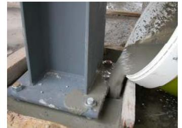
Após a descofragem cobrir a aplicação do Topeca Grout com lonas de plástico, panos húmidos ou Curing topeca, para proceder à cura húmida, durante 3 dias após a aplicação.
