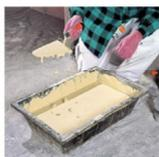
L'enduit tyrolien doit avoir une consistance liquide. Pour vérification, il doit rester environ un demi-centimètre d'épaisseur sur la truelle.
