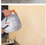
Orienter la machine face au support pour la première passe. Il n'est pas utile de trop épaissir le premier passage qui dépose un enduit assez aéré. Il s'agit plutôt de préparer une couche d'accrochage. N'insister que si cela est vraiment nécessaire.
