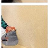
Effectuer deux passes, vers la gauche puis vers la droite, avec la machine orientée à 45° en veillant à travailler toujours par bandes horizontales. Les gouttelettes d'enduit s'accrochent ainsi sur la pointe du grain précédent pour l'épaissir; la couverture du support sera bien homogène. Uniformiser le revêtement en repassant au besoin.
