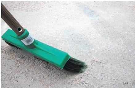
Os suportes têm de estar resistentes, coesos, secos e limpos (isentos de pó, óleos, gorduras, material frágil e/ou degradado, ceras, pinturas, etc). Se necessário proceder a operações de limpeza adicionais usando meios mecânicos que garantam a limpeza total dos suportes. Superfícies tratadas com hidrofugantes terão de ser previamente despolidas. Painéis de madeira/ placas compósitas devem cumprir os procedimentos de fixação preconizados, de modo a garantir total estabilidade.
