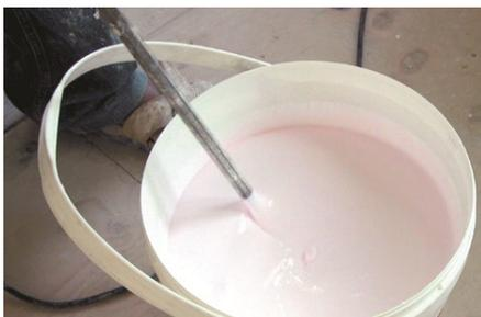
1. Homogeneizar o produto mecanicamente, a baixa rotação, ou manualmente.
