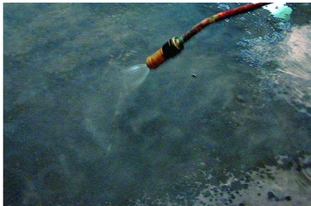
1. Agitar o Curing topeca antes da aplicação. Aplicar o Curing topeca por pulverização ou rolo de modo uniforme entre 200 a 300 ml/m<sup>2</sup>.
