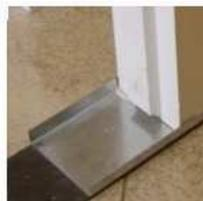
Para un mejor rendimiento, aislar el tabique del suelo aplicar la banda de estanqueidad al perfil, fijar al suelo y de esta manera evitaremos las dilataciones.
