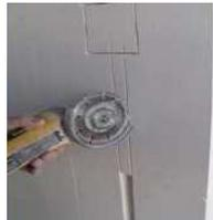
Para abrir las rozas se utilizará radial. Con disco de vidia, se dan dos cortes paralelos.
