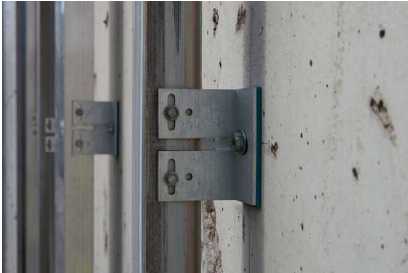
Figura 2.2.15 – Estrutura primária fixa com esquadros ao suporte
