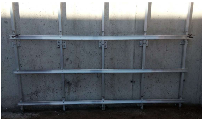
Figura 2.2.16 – Vista do perfil rail disposto na horizontal
