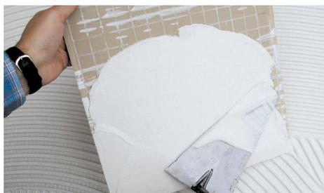
4. Ocasionalmente, comprovar a eficácia da técnica de colagem utilizada levantando ligeiramente uma das peças para observar se houve uma correta transferência da cola para o seu tardo.
