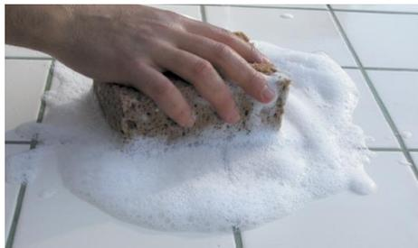
Garantir um suporte resistente, aderido, plano, seco (humidade  $\leq 4\%$ ) e limpo; isento de pó, óleos, gorduras, eflorescências, ou outro tipo de sujidades que impossibilitem ou dificultem a aderência da cola ao suporte. Verificar a planimetria do suporte e regularizar imperfeições superiores a 5 mm.
