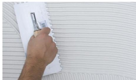
3. Colocar as peças sobre o cimento cola efetuando um ligeiro movimento perpendicular ao dentado, e bater as peças fortemente com recurso a um maço de borrada, de modo a conseguir o completo nivelamento dos sulcos e assegurar a total transferência da cola para o suporte e a peça. Respeitar as juntas entre peças, colocando cruzetas adequadas à sua largura.
