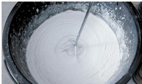
1. Misturar mecanicamente o conteúdo de um saco com cerca de 8 L de água limpa, até obter uma massa com consistência plástica e sem grumos.
