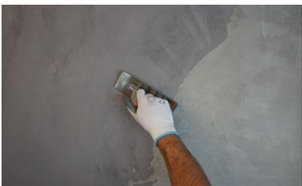
2. Appliquer Tubetão Microcimento FT (2 à 3 couches) à l'aide d'une spatule plate adaptée, en pressant bien la pâte contre le support, afin d'obtenir l'effet décoratif souhaité : lisse hétérogène, lisse hétérogène, brûlé vitrifié ou spatulé sur mesure. Laisser sécher le produit entre les couches. Enlevez toutes les imperfections de surface avec du papier de verre à grain fin (120-180), sauf pour la dernière couche.
