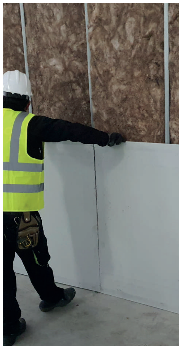
Instalação horizontal da Placa de Cimento SECOLITE®
