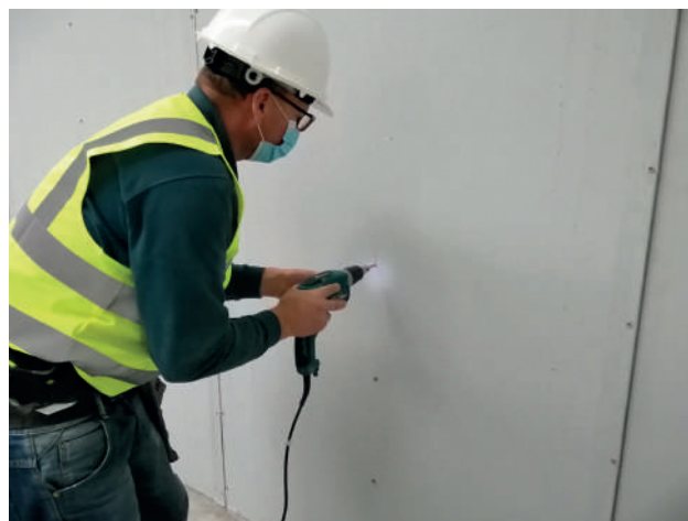
Fixação da Placa de Cimento SECOLITE® com Parafusos SECOLITE®
