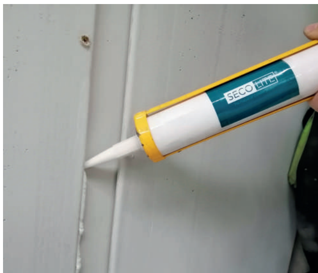
Instalando o Adesivo de Juntas SECOLITE®
