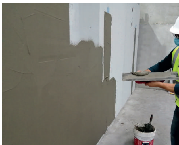
Acabamento superficial da Placa de Cimento SECOLITE® com a Argamassa Superficial e de Juntas SECOLITE®
