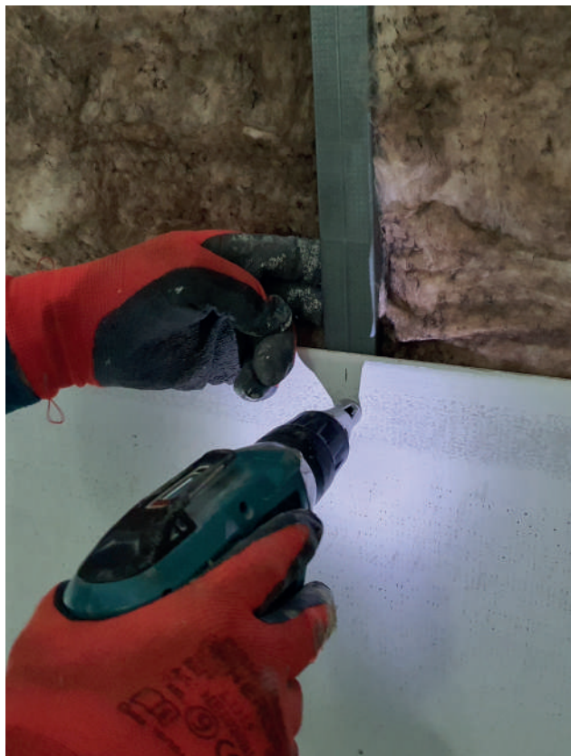
Fixação da Placa de Cimento SECOLITE® com Parafusos SECOLITE®
