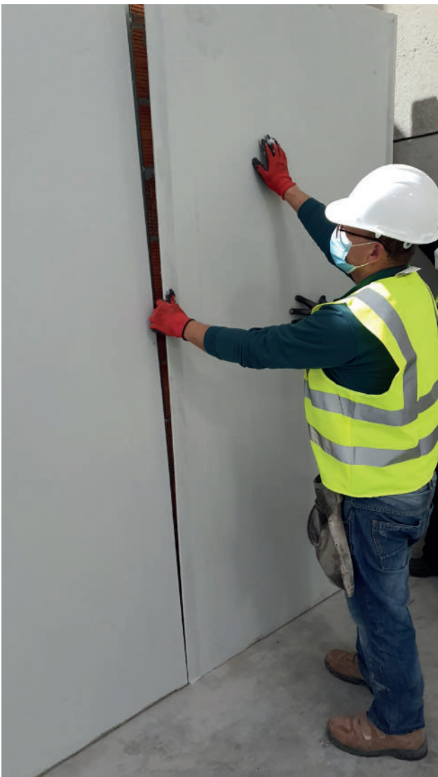
Instalação da Placa de Cimento SECOLITE®
