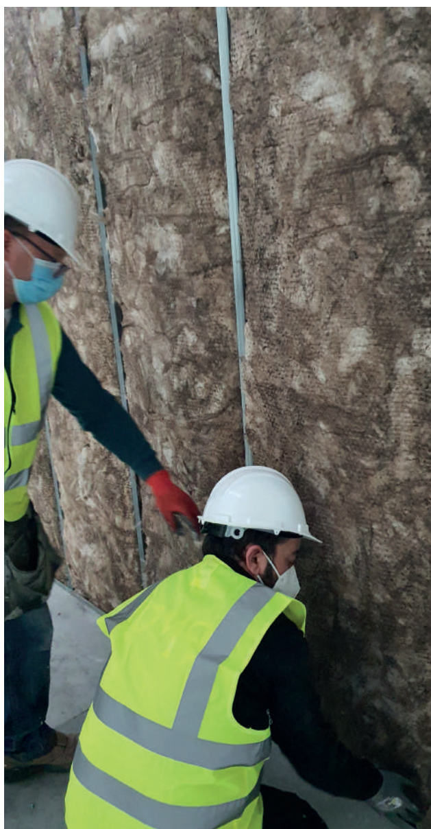
Instalação da Estrutura
