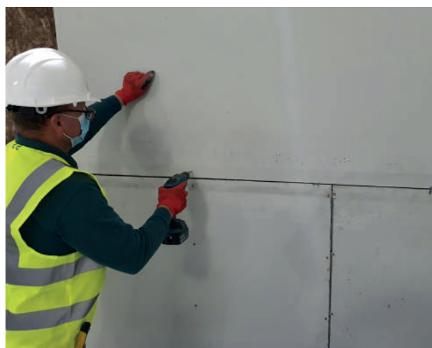
Placa de Cimento SECOLITE® com desfasamento de juntas correto
