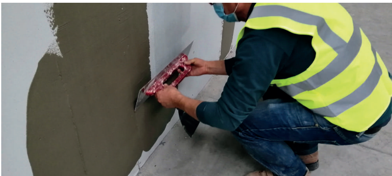
Revestimento da superfície da Placa de Cimento SECOLITE®
