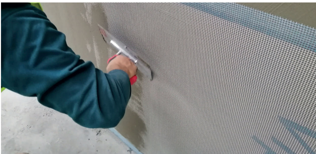
Assentamento da Malha de Reforço SECOLITE®
