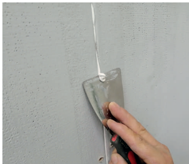
Remoção do excesso de Adesivo de Juntas SECOLITE®
