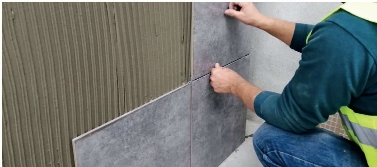
Instalação de cerâmicos nas Placas de Cimento SECOLITE®
