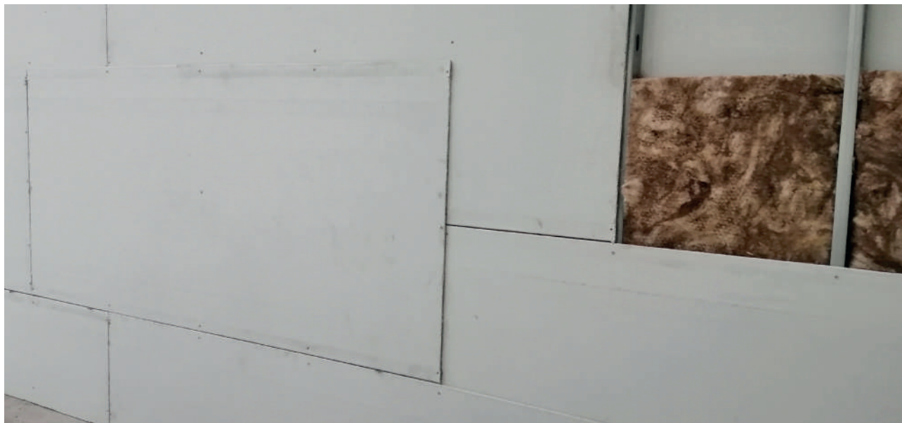
Instalação multicamada horizontal de Placas de Cimento SECOLITE®
