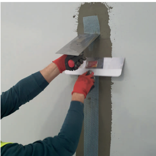
Colocação da Fita de Juntas SECOLITE®
