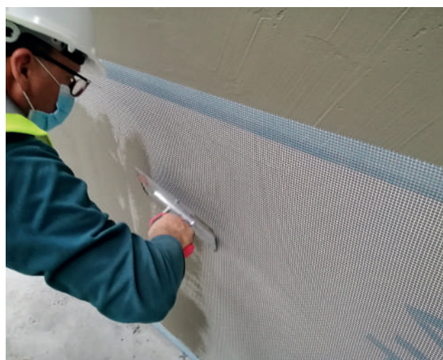
Instalação da Malha de Reforço SECOLITE®
